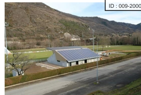
Figure 13 : Installation de Foix
