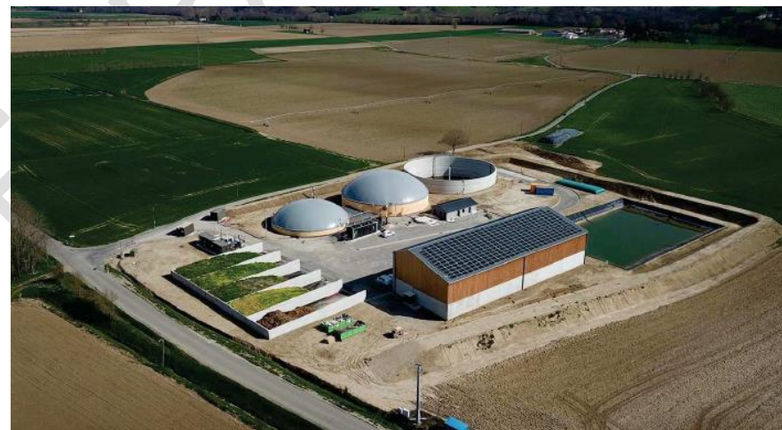
Figure 12 : Usine de méthanisation Ariège Biométhane à Ludiès
