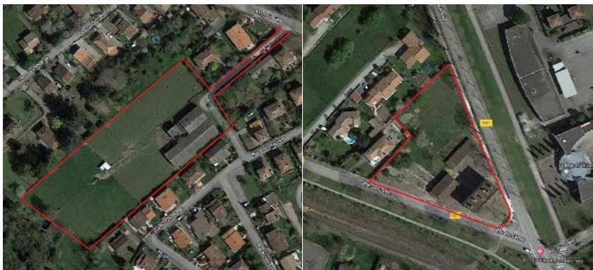
Figure 41 : Vues aériennes des friches de l'Ancienne Passementerie (à gauche) et de l'Ancienne Gendarmerie (à droite) à Saverdun
