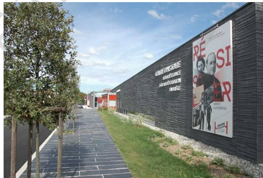
Figure 12 : Pôle culturel de l'agglomération à Varilhes
